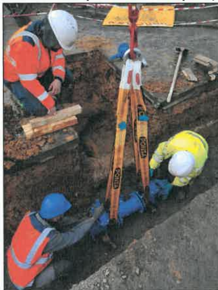
Chantier de renouvellement d'une conduite en amiante-ciment sur la commune de Saint-Vincent-du-Lorouër
