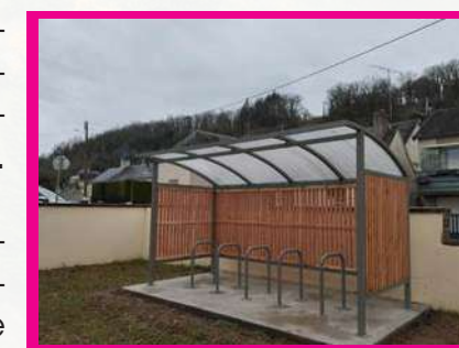
@ Abris à vélo à Vouvray-sur-Loir, 2025
