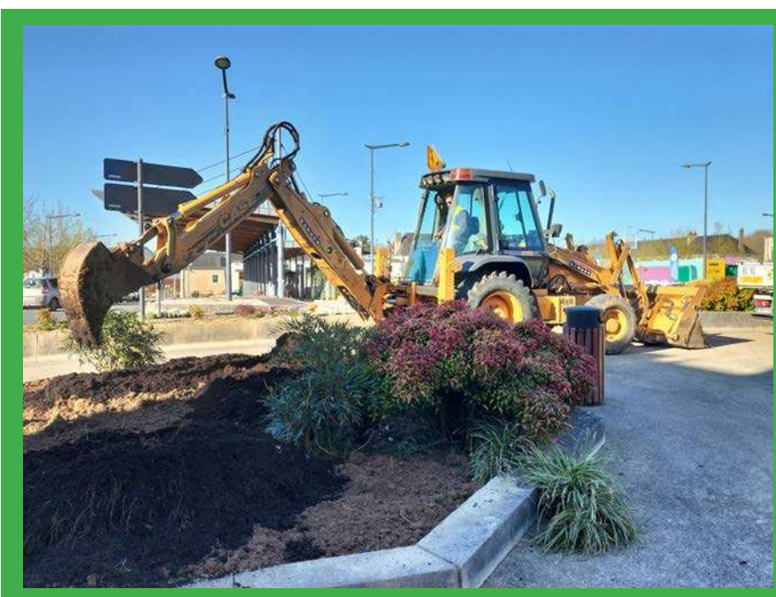
@ Les services techniques réaménagent les massifs devant la mairie de Château-du-Loir, 2025
