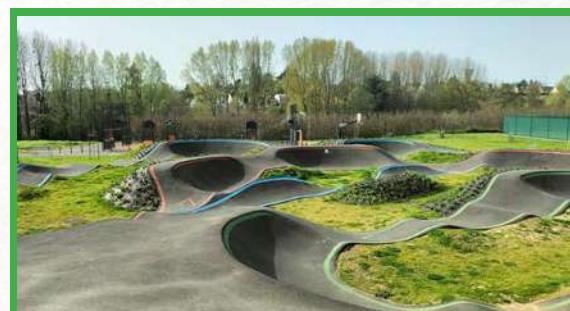
@ Aménagement du pumptrack, 2025
