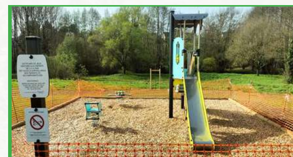
@ Travaux de l'aire de jeux des Paumons, 2025
